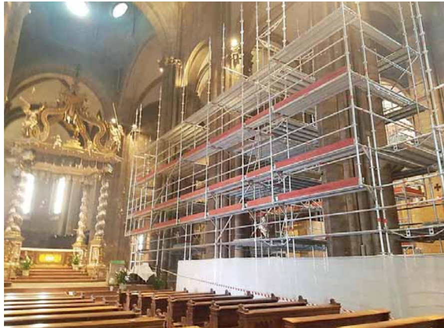
• Le impalcature all'interno della Cattedrale di San Vigilio
