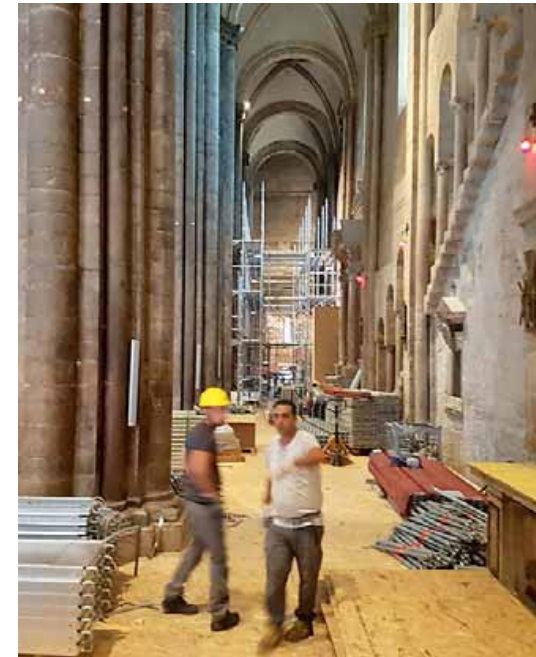
• Operai al lavoro lungo la navata
